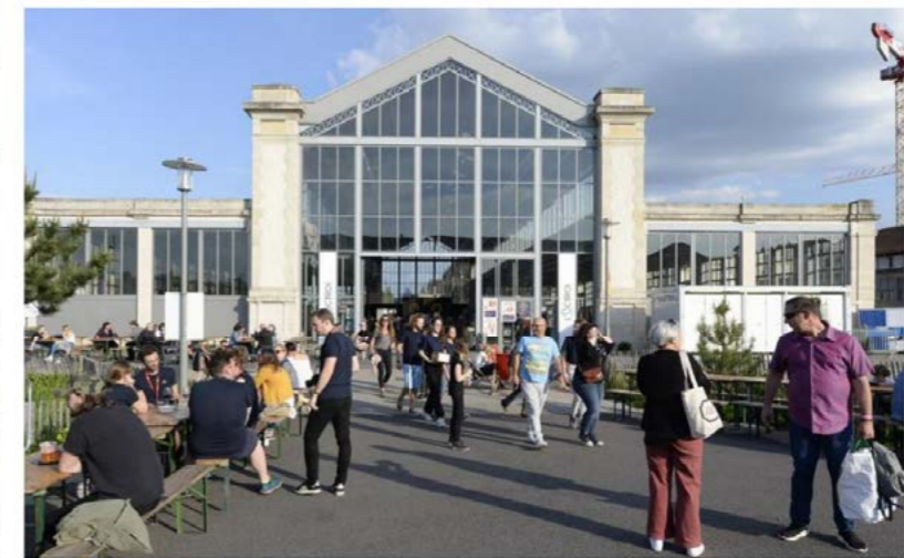
L'exploitation de la grande halle (anciennement halle renaissance), sur le site de l'Octroi, sera gérée par L'Autre Canal pour la durée des quatorze mois d'expérimentation qui vise également à repenser l'environnement paysager autour des bâtiments. Photo Frédéric Mercenier
